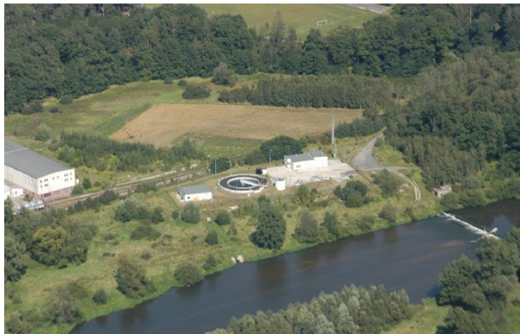
Fot. 2. Oczyszczalnia w Nowogrodzie Bobrzańskim (źródło: UM Nowogród Bobrzański)
