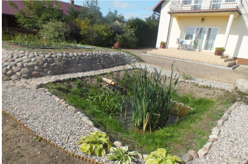
Rysunek 18. Oczyszczalnia hydrofitowa
