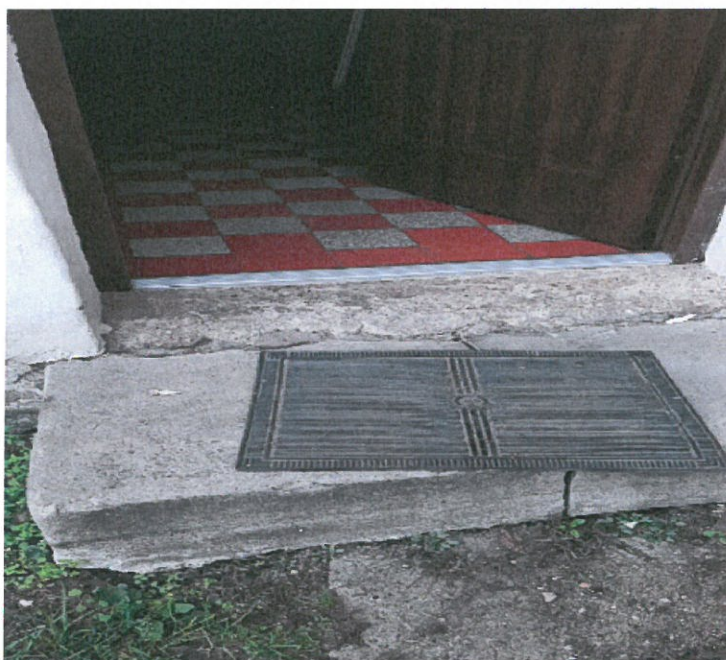
Próg wejściowy do budynku nr 14 od podwórza budynku – odtworzenie z cegły klinkierowej na rąbek
